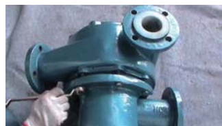
30. 对角均匀拧紧泵壳与轴承座的连接螺栓
