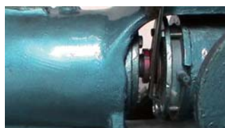
45. 对角均匀拧紧密封盒压盖上的紧固螺栓
