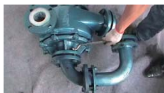
47. 逐一将所有弯头接管螺栓对角均匀拧紧
