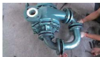
46. 安装弯头接管, 注意不要遗漏垫床
